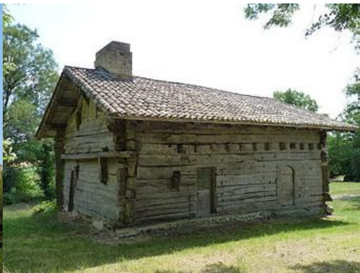
Maison à empilage de poutres de Saint-Germain à Beaumontois-en-Périgord, MH classé (source : wikipédia)
