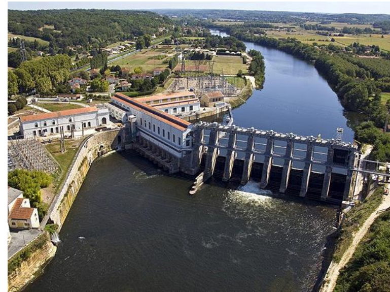
Centrale hydroélectrique de Tuilières – Source : www.entrepriseetdecouverte.fr
