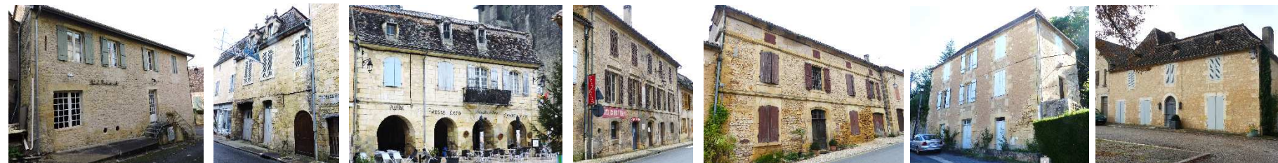
Les maisons de bourg et maisons bourgeoises, alignées sur rue et mitoyennes, traduisent un patrimoine urbain du Moyen-Âge au XIXe siècle
