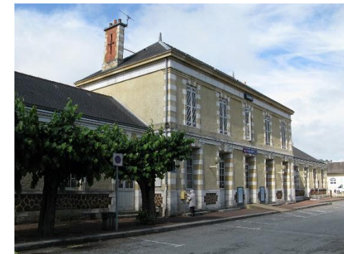
Gare TER de Le Buisson-de-Cadouin
