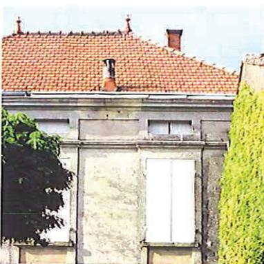
Quelques toitures sont couvertes de **tuiles mécaniques de couleur rouge** : toitures traditionnelles remontées, ou coiffant des édifices construits en milieu de siècle.
