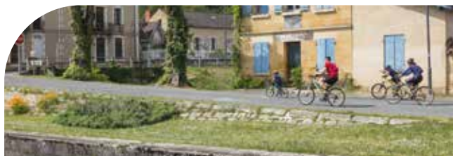
TRAVAUX ENTRE PORT DE COUZE ET LALINDE POUR LONGER LE CANAL ET CRÉER UNE CONTINUITÉ AVEC LA « VÉLO-ROUTE VOIE VERTE ».
